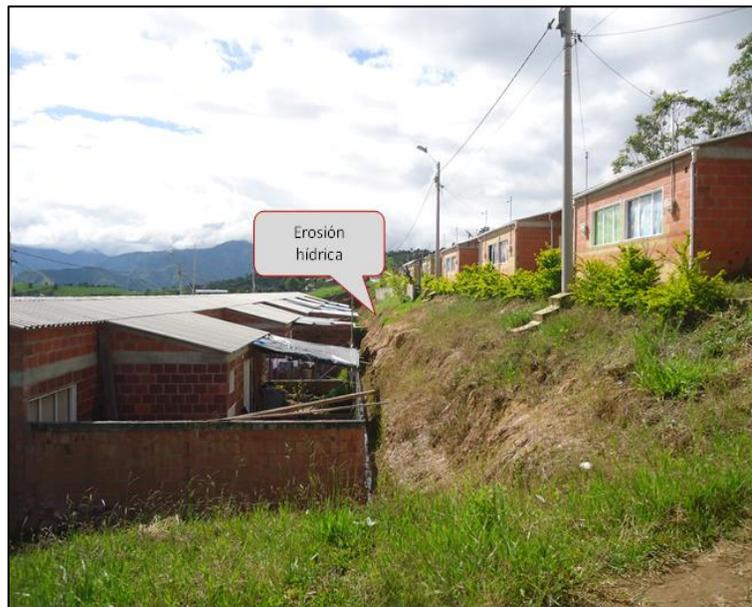
**Ilustración 39.** Fotografía tomada hacia el noroccidente. Erosión laminar y en surcos de leve a moderada magnitud en un talud realizado para la adecuación de terrenos para construcción de viviendas en la zona de expansión de Nátaga.
