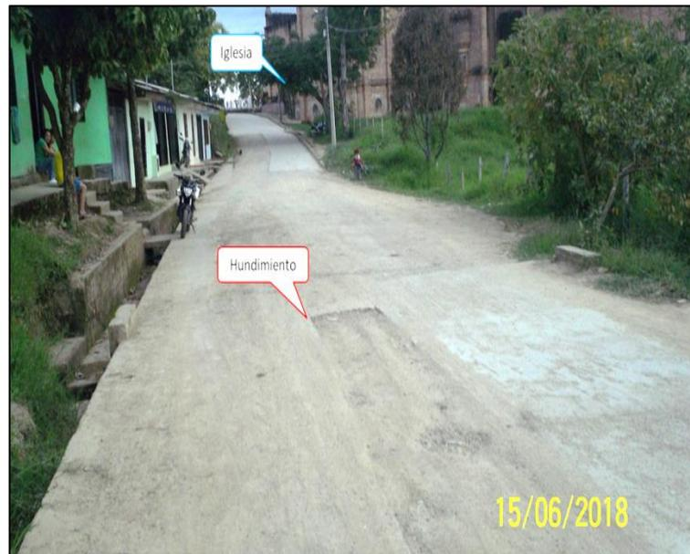
**Ilustración 44. Hundimientos en la vía al oriente de la iglesia**
