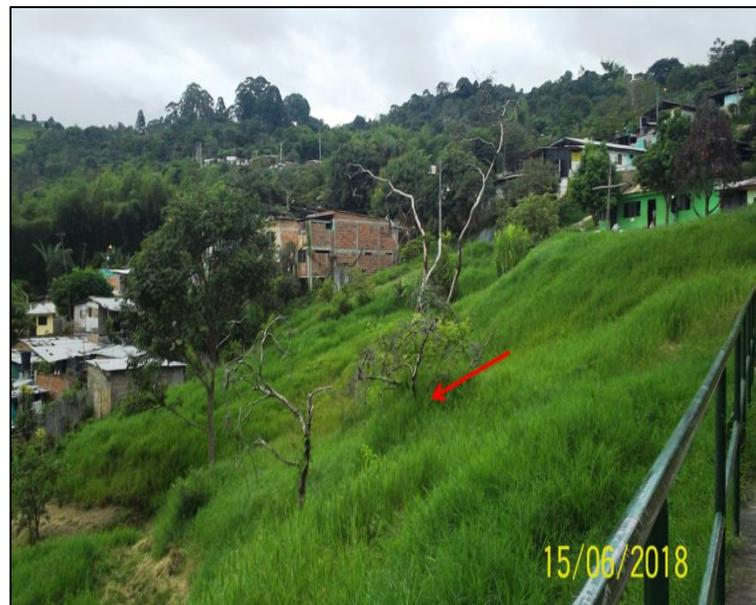
**Ilustración 45. Deslizamiento rotacional en un predio contiguo a la iglesia. Nótese los hundimientos en forma de cuchara característicos en este tipo de deslizamientos, además de las irregularidades en la superficie del terreno que pueden indicar que el movimiento es relativamente lento. Con la flecha roja se indica el vector principal de desplazamiento, de suroriente a noroccidente**
