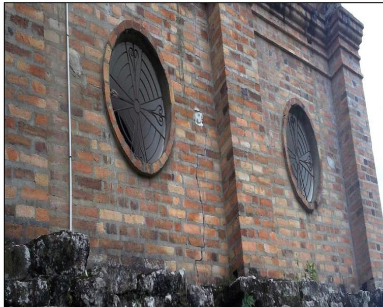
**Ilustración 120. Fracturas generadas por el movimiento en masa en las paredes de la Iglesia.**
