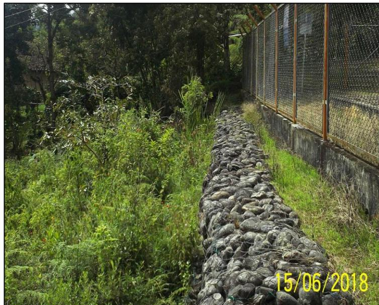
**Ilustración 212. Deformación de los gaviones como consecuencia del Movimiento superficial tipo reptación hacia el extremo nororiental de la zona de estudio.**
