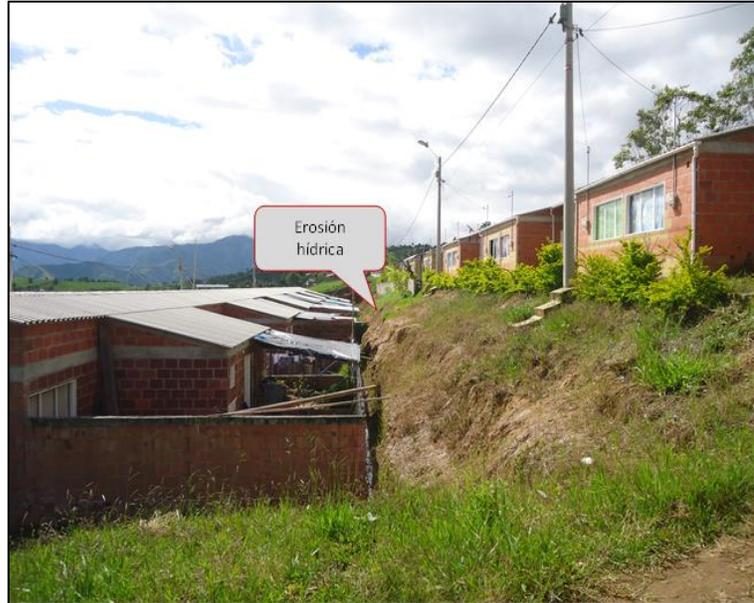
**Ilustración 122. Erosión laminar y en surcos de leve a moderada magnitud en un talud realizado para la adecuación de terrenos para construcción de viviendas en la zona de expansión de Nátaga.**
