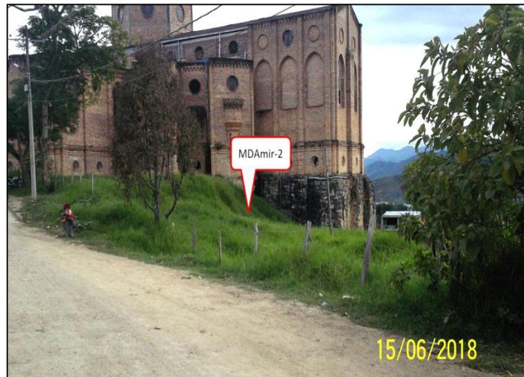
**Ilustración 31. Geoforma de origen Mixto Denudacional – Agradacional, Laderas en movimiento o con inestabilidad reciente (MDAmir-2) generada por un deslizamiento tipo Rotacional**
