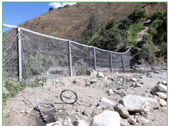
Barrera dinámica contra flujo de detritos de tipo UX Geobrug, sobre el río Las Ceibas paralelo al Km 38 de la vía Neiva – Balsillas.
