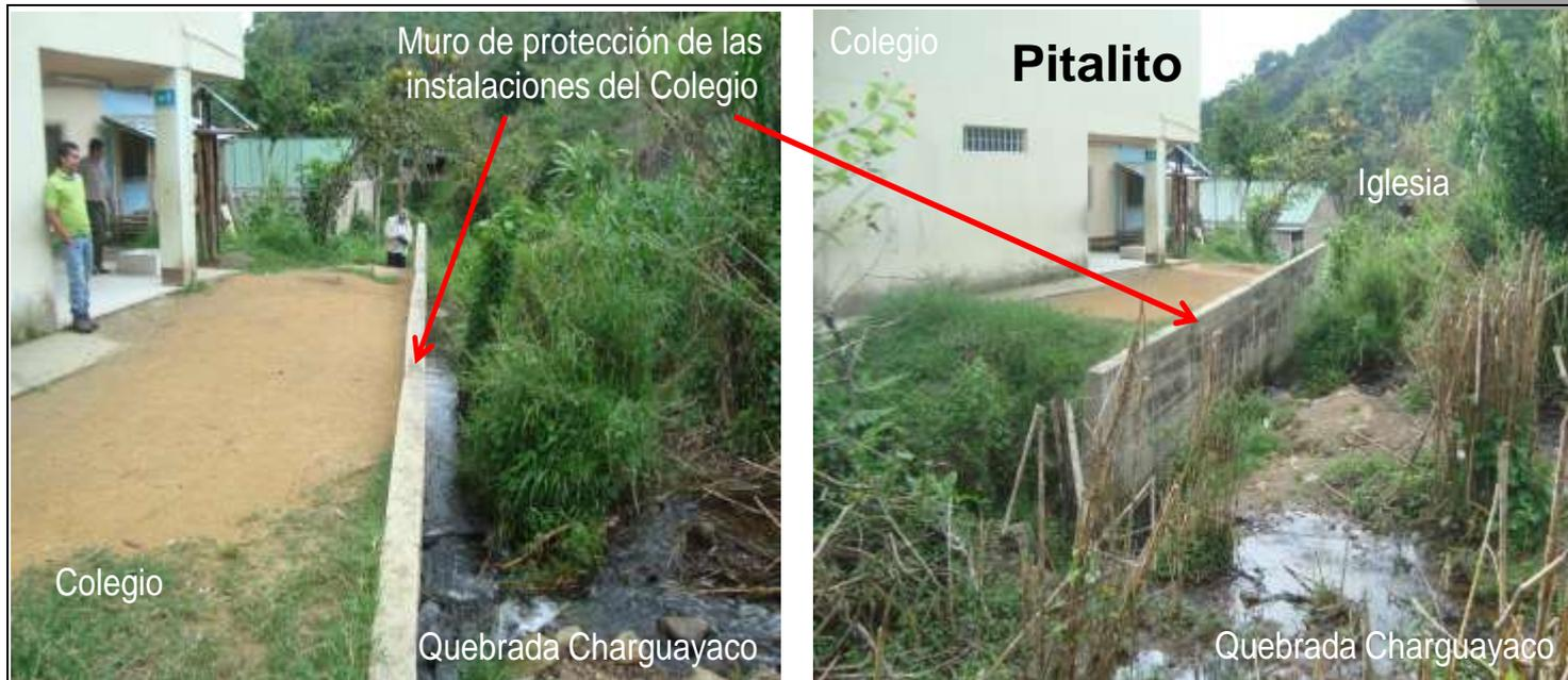
Fotografías que muestran el muro de protección construido al costado del colegio. Se observa socavación y debilitamiento de la estructura. El flujo golpea en dirección frontal al mismo. Es evidente la invasión de la ronda de la quebrada y la amenaza de origen hidrometeorológica. Al fondo en la fotografía de la derecha se observa la Iglesia construida invadiendo igualmente la ronda de la fuente hídrica.
