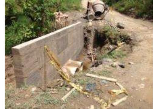
CONSTRUCCION DE UN MURO DE CONTENCIÓN EN CONCRETO CICLOPEO SOBRE LA MARGEN IZQUIERDA DEL PUENTE SOBRE LA QUEBRADA LAS ENJALMAS PARA EL SOSTENIMIENTO DE TALUD Y ENCAUSAMIENTO DE LAS AGUAS DE LA QUEBRADA LAS ENJALMAS
