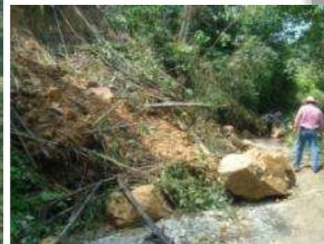
Fotografías que muestran la vía Guasimos-La Lupa (Palermo), afectada por fenómenos de remoción en masa.
