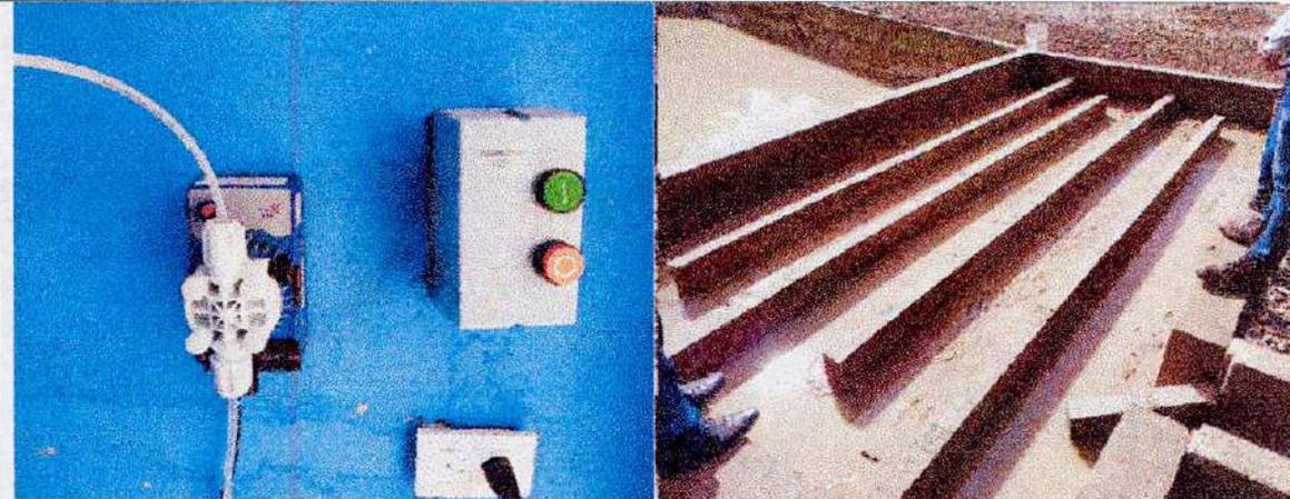
Fotografía 12. Bomba dosificadora de coagulante
