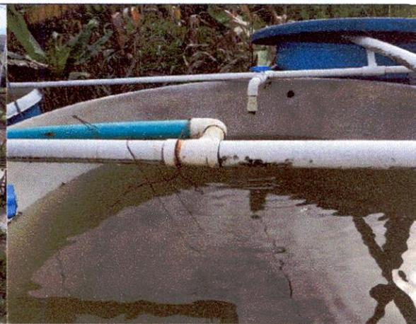
Fotografía 6. Sistema de alimentación de tanques de almacenamiento.
