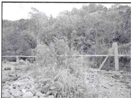
Paso de la tubería sobre el cauce de la quebrada Matanzas
