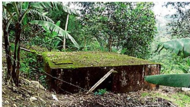
**Fotografía 7.** Tanque de almacenamiento para posterior distribución del agua.
