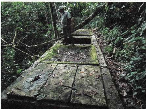
Fotografía 3. Tanque desarenador
