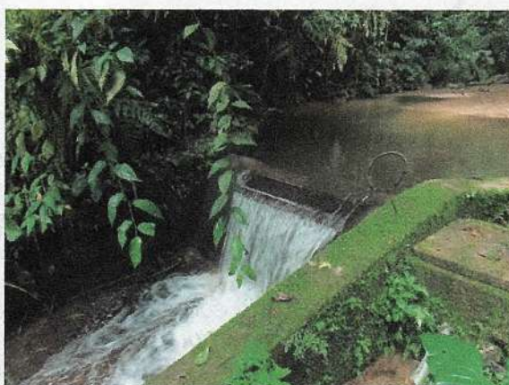
Fotografía 6. Estructura de captación Tipo diquetoma.
