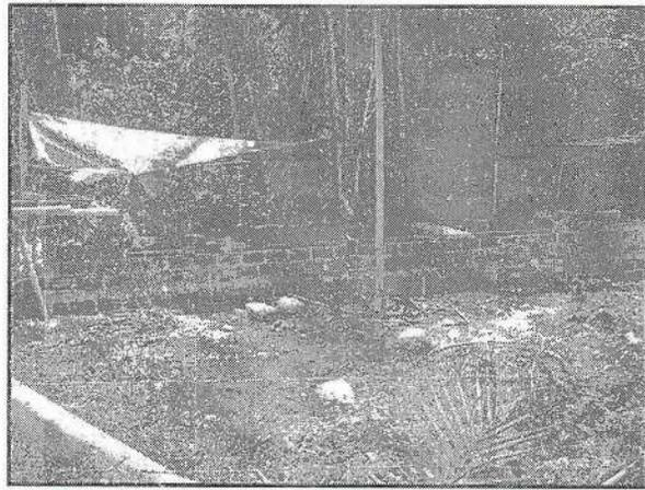
Se observan dos mangueras que llevan el agua desde la captación hasta un primer tanque de donde se deriva el agua para los tres estanques.
