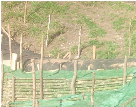
*Filtro en piedra revestido en geomembrana protegido por trinchos y revestido en geomanto*
