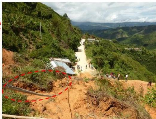
Imágenes que muestran un sector de la vía Acevedo-Pitalito en la vereda Alto Bellavista (Acevedo), afectado por un (FRM) fenómeno de remoción en masa. Se observa la presencia de varias mangueras plásticas utilizadas para el transporte de agua, ubicadas precisamente en el sector del deslizamiento.
