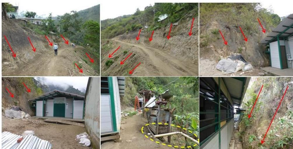
Fotografías de la escuela de la vereda Agua Fría del municipio de Rivera, amenazada por fenómenos geomorfológicos (caída de bloques, hundimientos por manejo inadecuado de drenajes y aguas servidas y por la construcción de una vía que afectó la base del talud donde se localiza la escuela).
