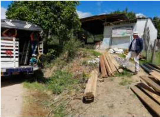
Entrega de materiales para construcción de batería sanitaria y pozo séptico - vereda Vergel
