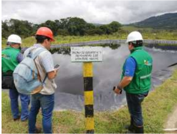
Piscina de lixiviados
