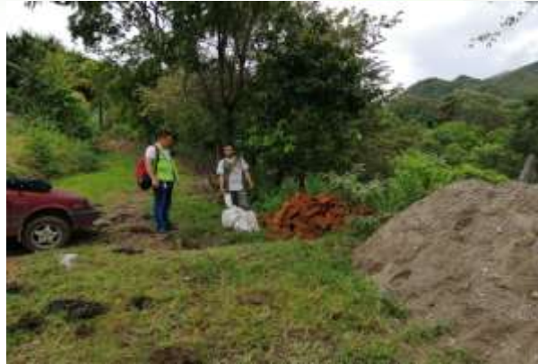
Entrega de materiales para construcción de batería sanitaria y pozo séptico - vereda Floragaita.
