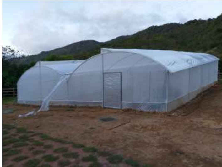
Construcción de invernadero, predio la Colonia- vereda la Plata
