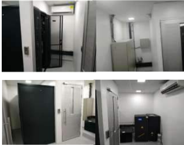
Adecuaciones Data Center
