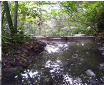
Mejoramiento de la captación
