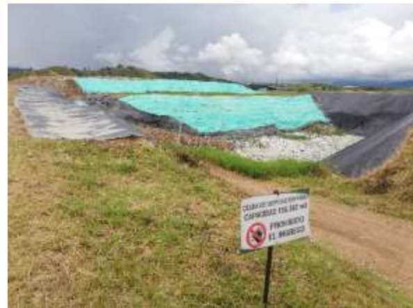
Celda de disposición final
