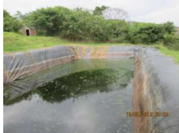
Piscina de Lixiviados
