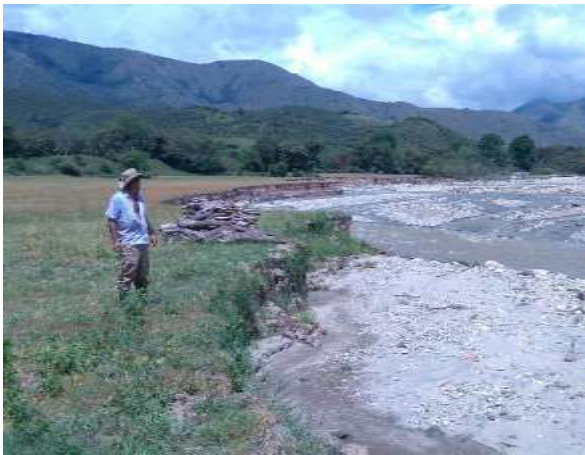
Daños en la captación del recurso y destrucción de los Predios Río Neiva - Campoalegre
