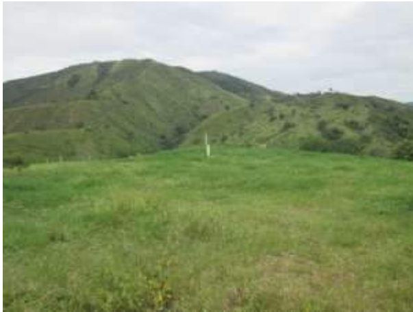
Celda de disposición final
