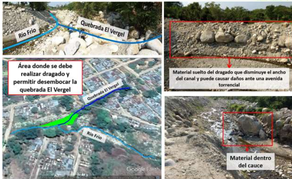
Seguimiento a obras en el Río Frío municipio de Campoalegre Huila.
