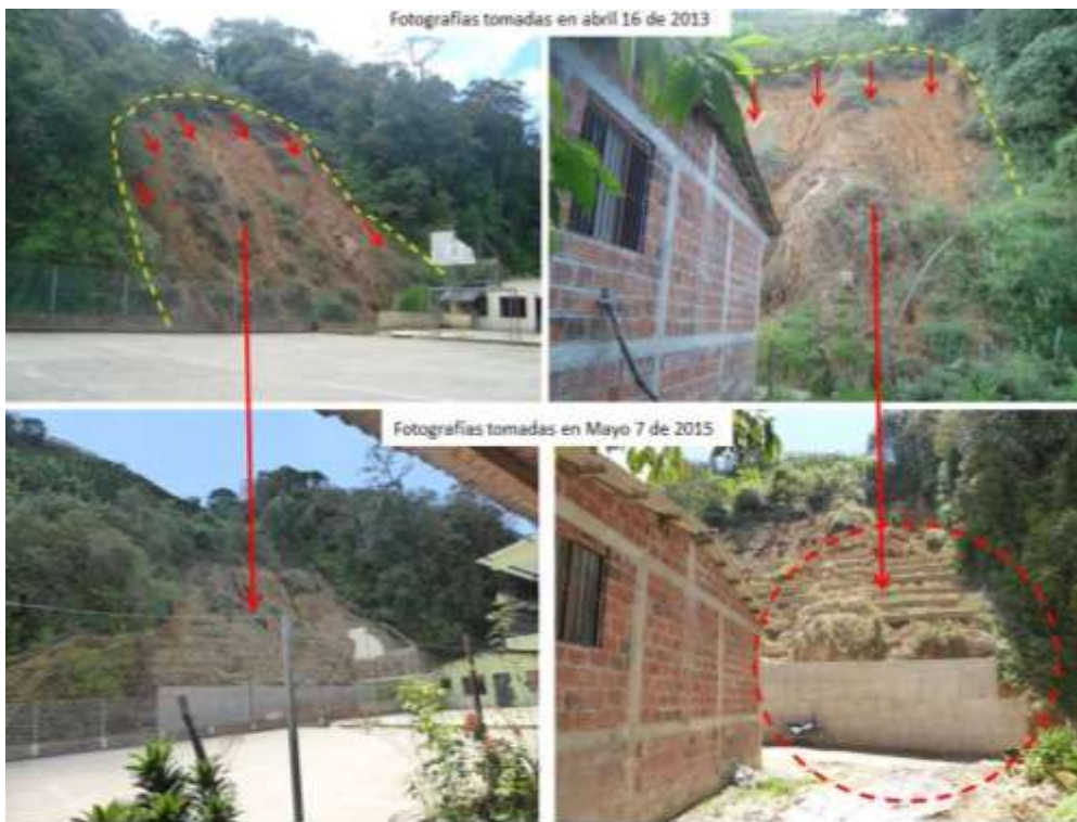
Fotografías tomadas en 2013 y 2015 que muestran la escuela Villa María de Iquira y las obras de mitigación (muro y obras de bioingeniería-trinchos-) recientemente construidas.
