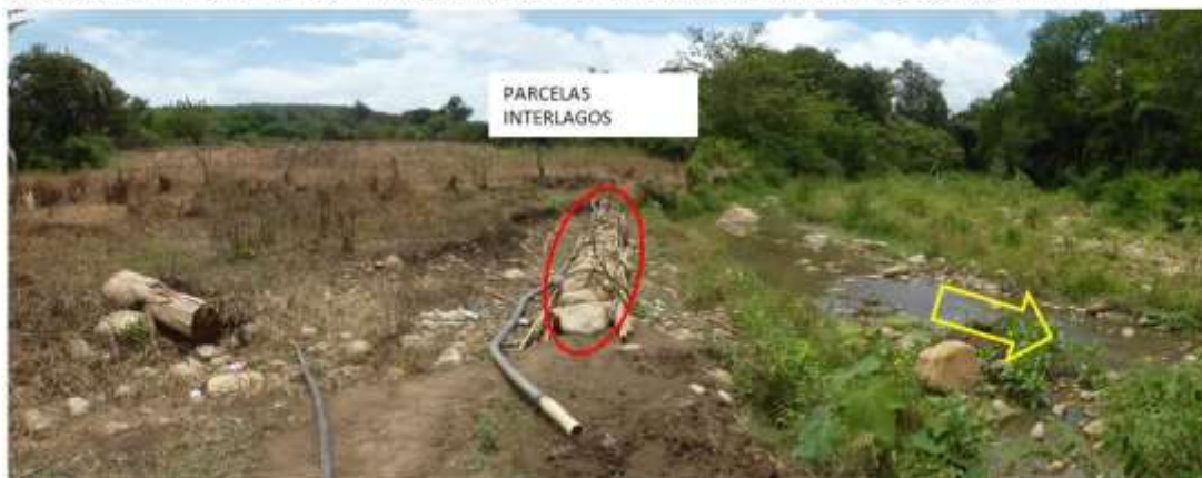
Quebrada La Nutria, en el sector Interlagos. Nótese una obra en piedra construida para proteger la orilla.
