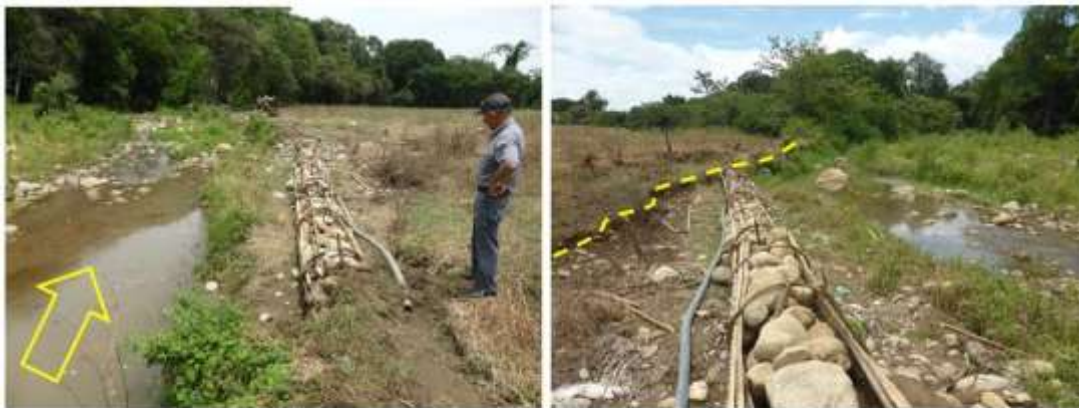
Quebrada La Nutria, en el sector Interlagos. Nótese una obra en piedra construida para proteger la orilla.
