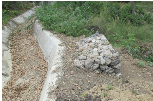
Construcción de gaviones para proteger canal revestido en concreto
