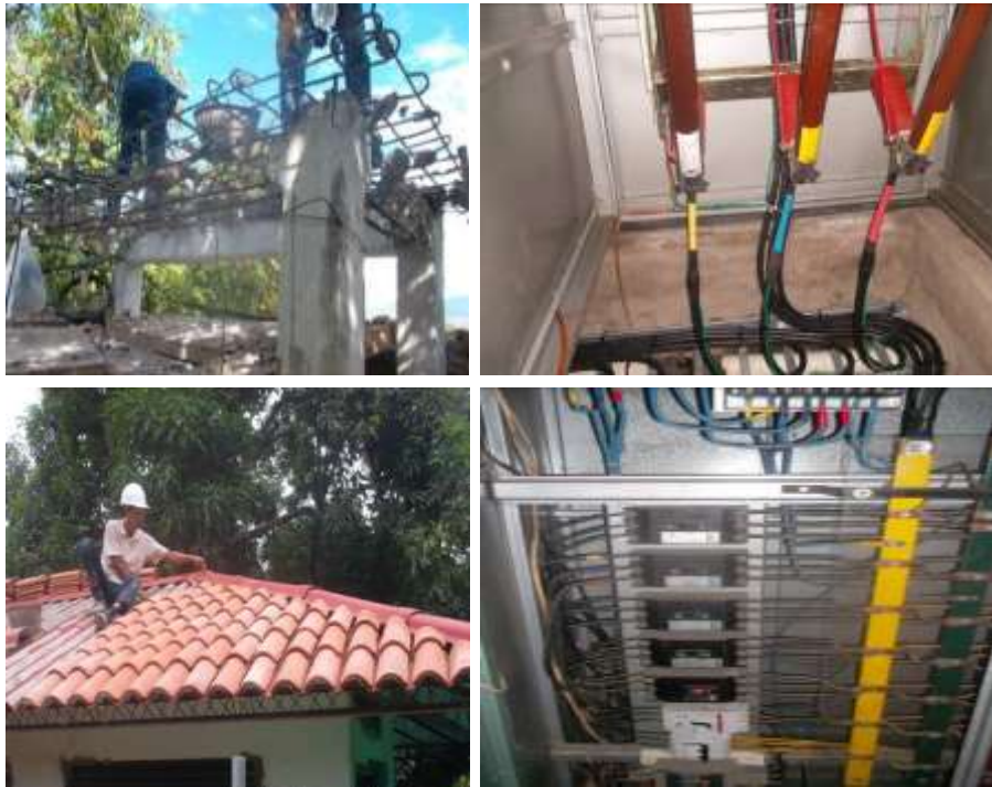
Adecuaciones en la subestación eléctrica
