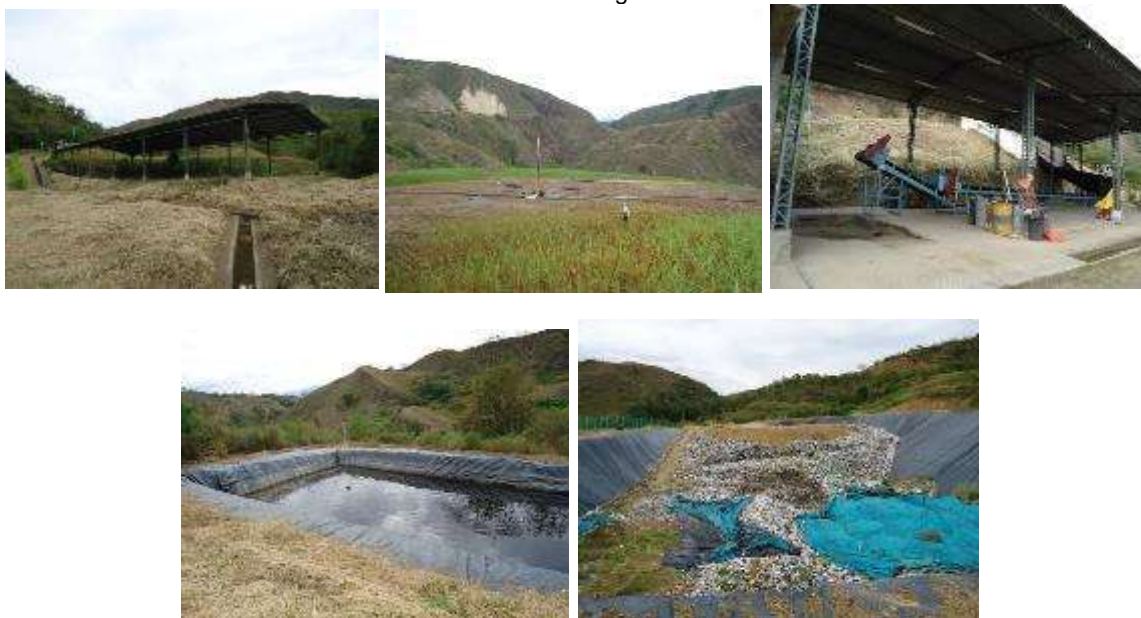
Estado actual Planta Biorgánicos del Centro
