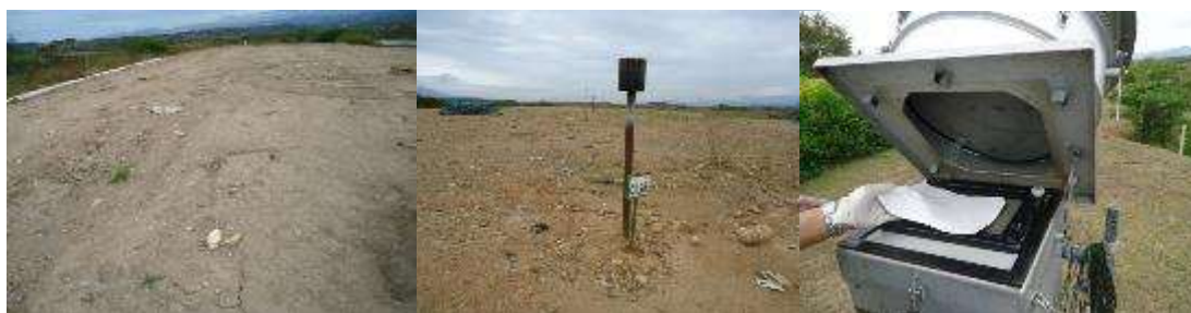
Estado actual del Relleno Sanitario Los Ángeles
