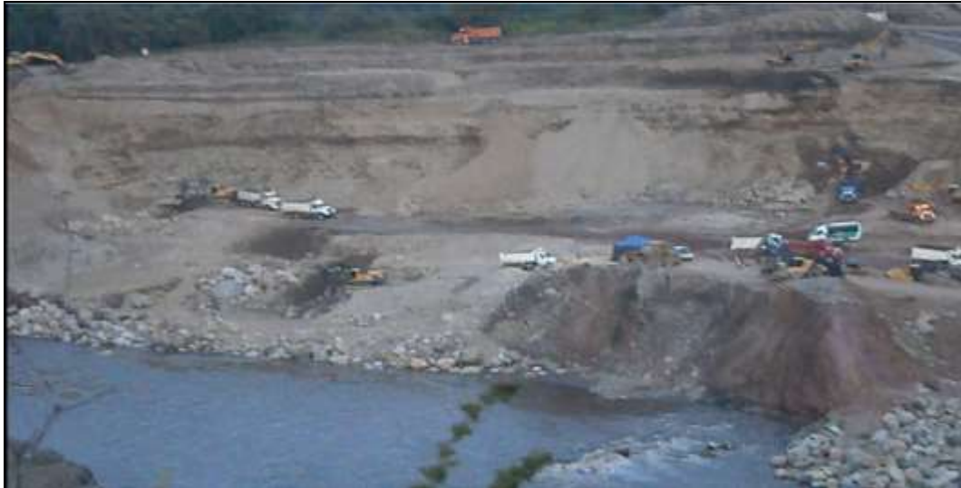
Foto No. 165 Registros fílmicos tomados el día 04 de marzo, en el área de explotación “Paisito”, en donde se observa la maquinaria sacando material por fuera de las áreas licenciadas. Fuente: RED RIGOBERTA.
