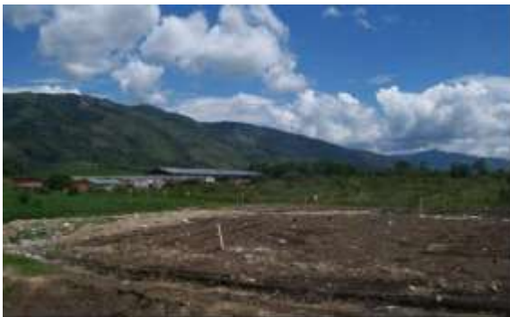
Foto No. 91 Celda sin terminar de clausurar Chimeneas enterradas 2012
