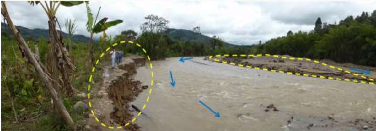
Imágenes que muestran la vía a la vereda El Rubí, destruida por el río Suaza, en un sector de la vereda Guaduales. Nótese como la barra controla la dirección de la corriente dirigiéndola hacia la vía.
