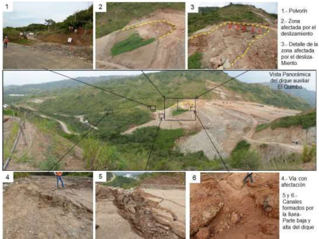
Foto No. 131 a 137 Seguimiento Riesgos por deslizamiento dique auxiliar Proyecto Quimbo - PHEQ.
