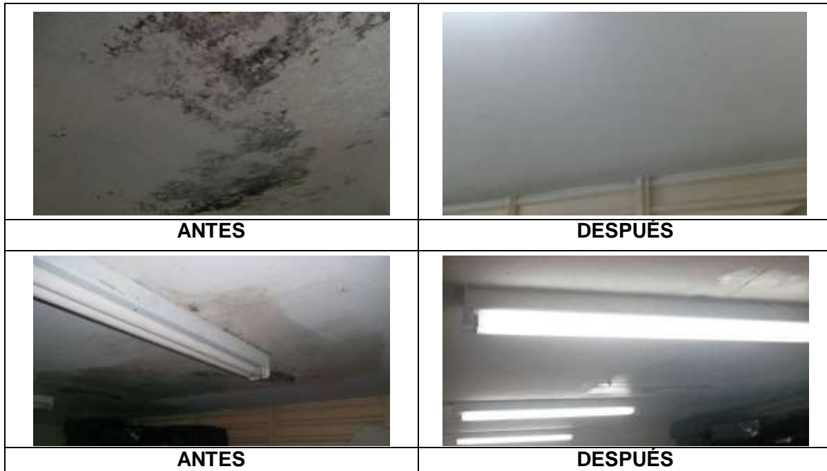
Foto No. 190 y 191 Adecuaciones Bloque 1 Sede Principal
