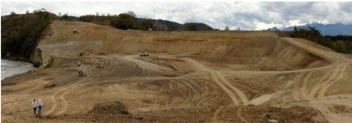
Foto No. 166 Registros. Desarrollo de actividades de recuperación y perfilamiento de los taludes que se generaron en la extracción anti técnica de los materiales de construcción.
