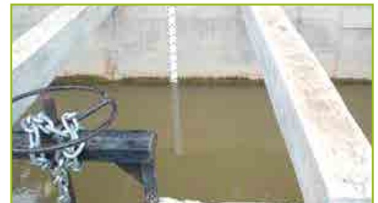
Obras de control – Mpio de Tello.
