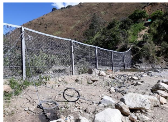
Red de anillos y anclajes de la barrera dinámica UX180-H6-Espec
