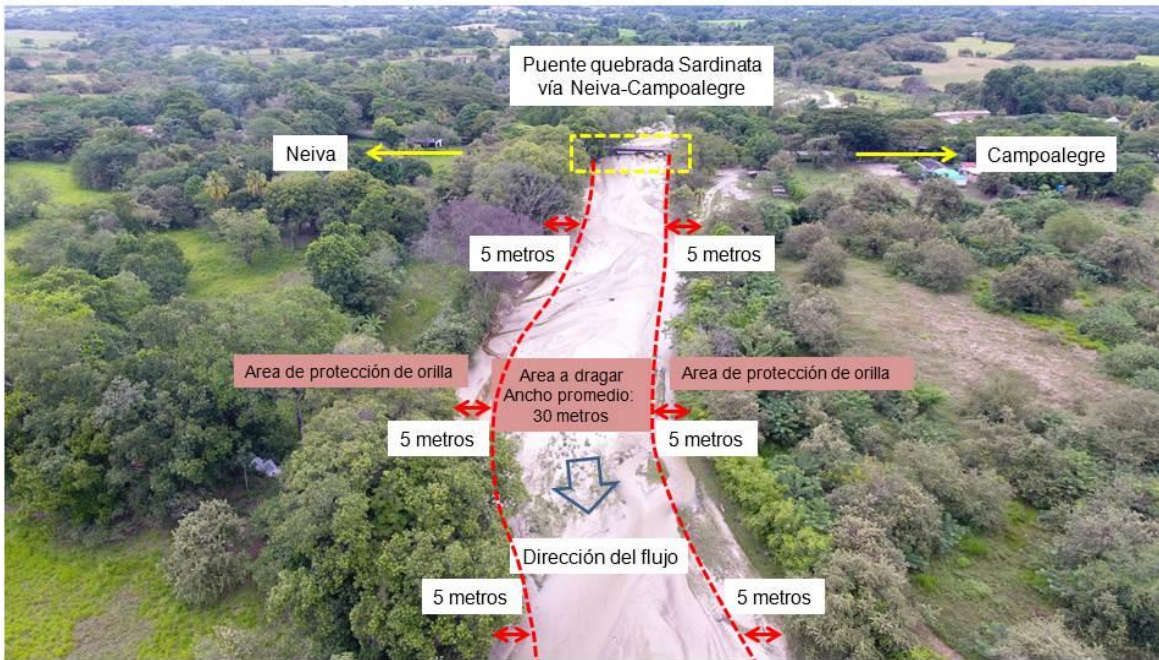
Fotografía Quebrada Sardinata (Vía Neiva – Campoalegre), aguas abajo del puente
