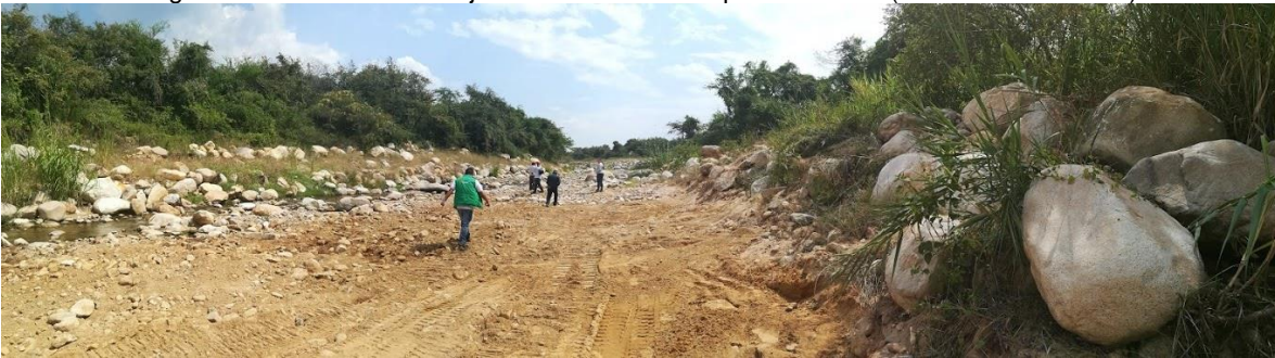
Seguimiento a UPM Material de Construcción (Arrastre) jurisdicción del municipio de Rivera. (Título minero ECJ-083).
