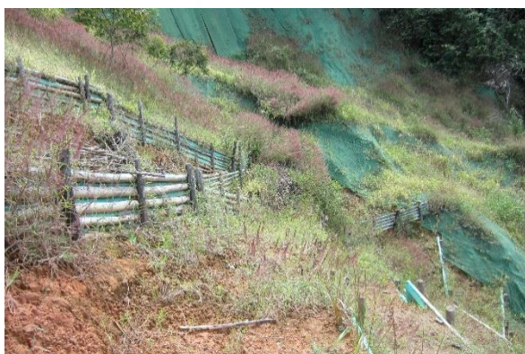
Obra de bioingeniería, parte corona del deslizamiento en predio Ginebra.
