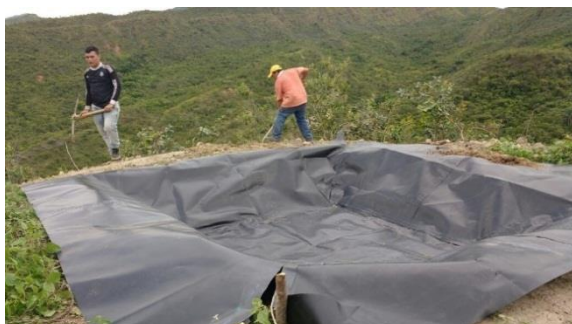
Construcción de tanque de agua en predio de Luis Alejandro Herrera, Rancho Ovino San Pablo, Vereda Ceibas Afuera.
