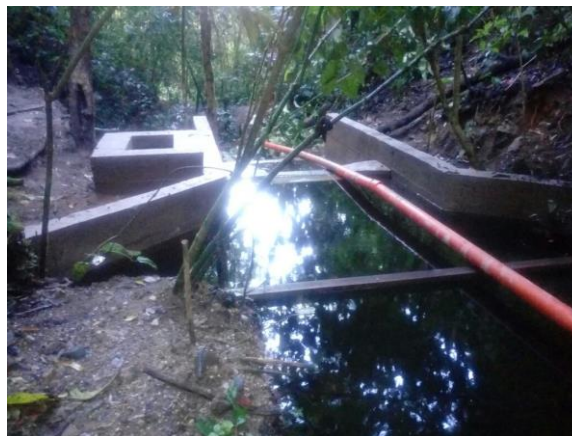
Construcción de la Bocatoma para el abastecimiento de agua al Centro de Promoción Ambiental de Investigación en Biomás Andinos, en predio La Colonia, vereda La Plata. Diciembre 2017.
