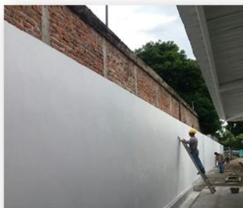
Levantamiento de muro y cerramiento Sede Principal
