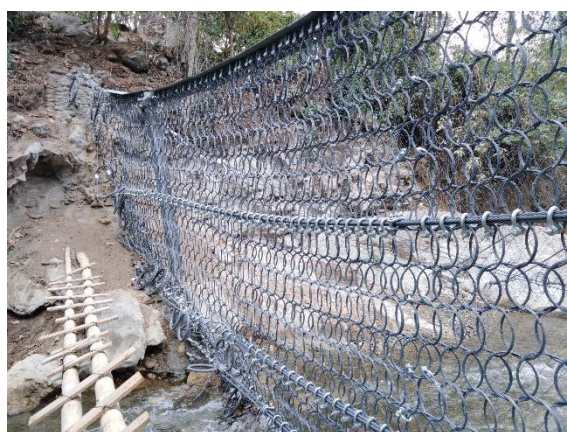
Construcción de la barrera dinámica UX180-H6-Espec, que se ubica sobre el río Las Ceibas, paralelo al Km 18 de la vía Neiva – Balsillas.
