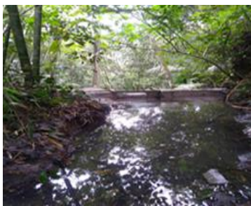
Mejoramiento de la captación
