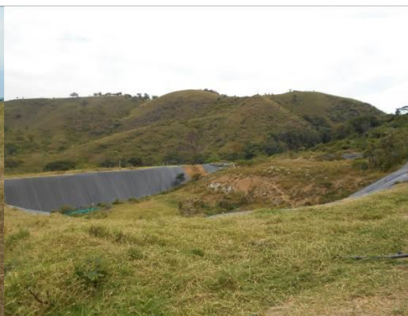
Celda de disposición final No. 3
