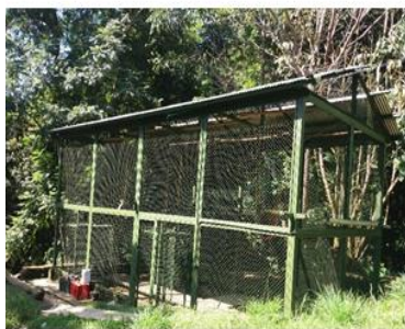
Reconstrucción de jaulas - CAV
