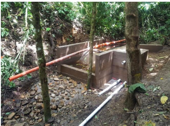
Construcción de la Bocatoma para el abastecimiento de agua al Centro de Promoción Ambiental de Investigación en Biomás Andinos, en predio La Colonia, vereda La Plata. Diciembre 2017.
