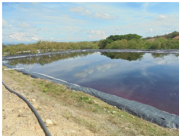
Piscina de lixiviados del sector II
