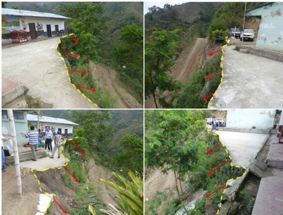
Fotografías movimiento en masa en la escuela de la vereda Agua Fría del municipio de Rivera.
