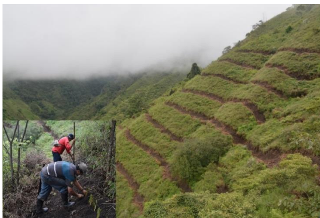
Panorámica con barreras vivas de zanjas de infiltración predio El Cedral vereda Pueblo Nuevo.
