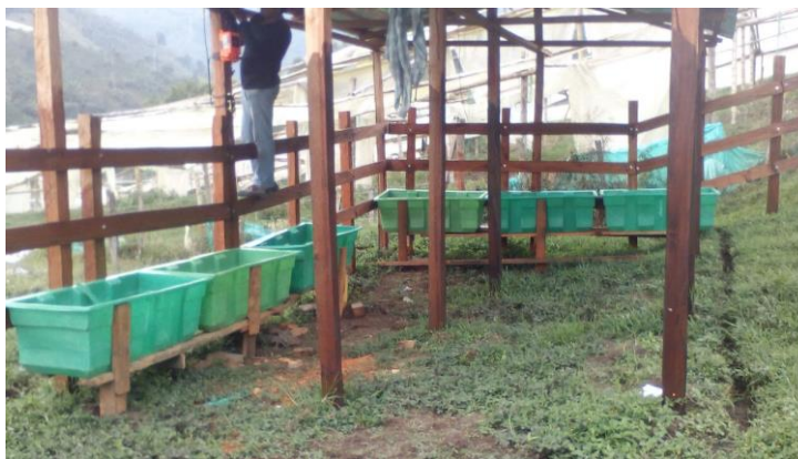
Establo construido beneficiaria Mireya Rojas, Vereda Montecristo Municipio de Pitalito
