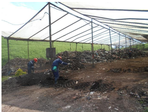
Zona de compostaje
