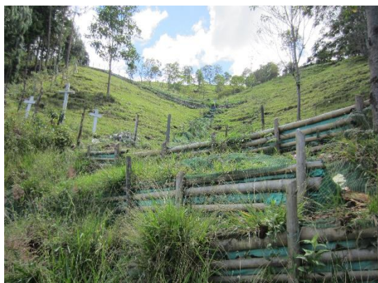
Obra de bioingeniería, previo a la corona del deslizamiento en predio Miraflores. Controlar agua por escorrentía.
