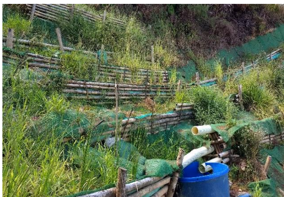
Obra de bioingeniería, parte corona del deslizamiento en predio Miraflores.
