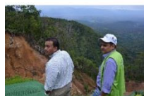
19-05-16 Visita técnica obras de geotenia Ginebra - Miraflores
