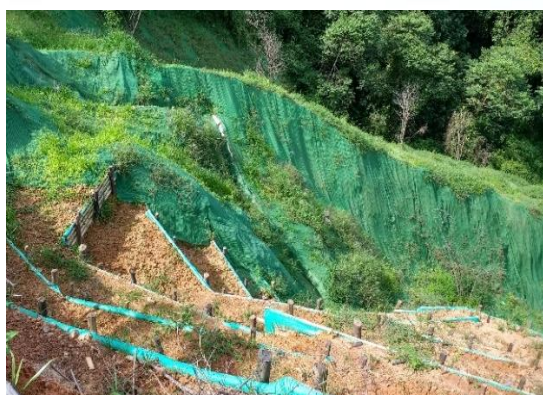
Obra de bioingeniería, parte cuerpo deslizamiento en predio Ginebra. Proceso de vegetalización.
