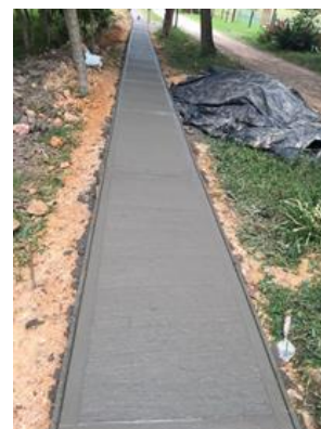
Construcción Vía Peatonal - Marengo
