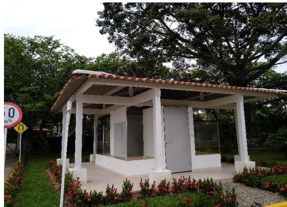
Estación de Residuos Peligrosos
