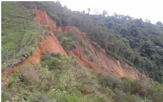
Deslizamiento en el predio Ginebra, febrero 2016.
