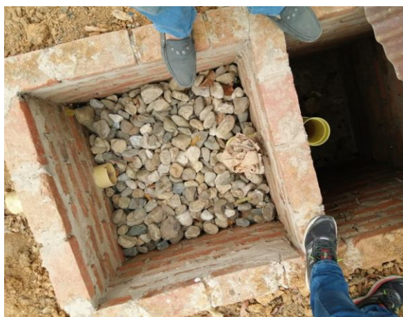
Pozo séptico construido vereda Santa Lucia Beneficiario Juan Manuel Polanía
