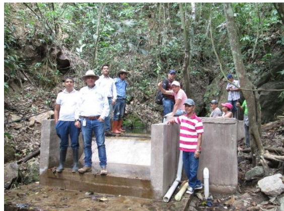
Bocatoma de Fondo
