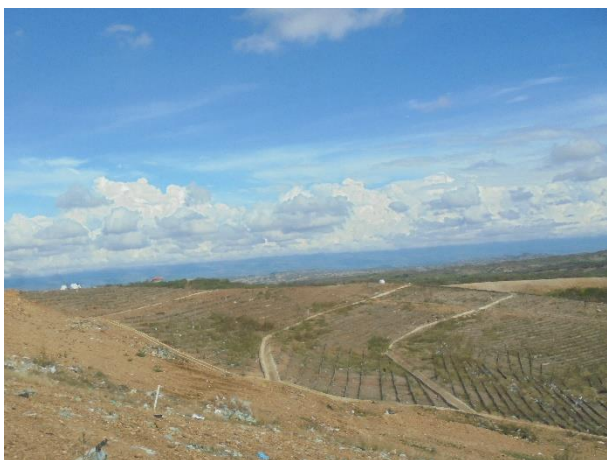
Celda No. 3 en proceso de clausura
