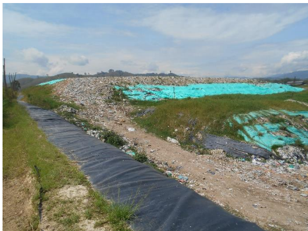
Celda de disposición final
