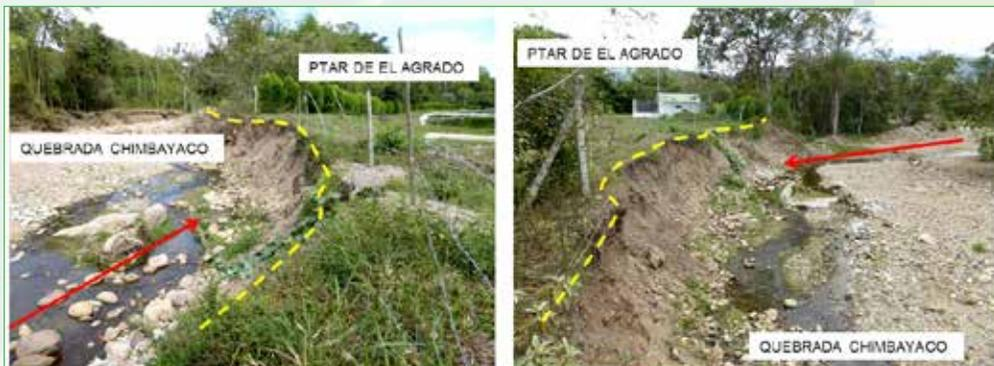
Fotografías con dirección aguas abajo (izquierda) y aguas arriba (derecha) de la quebrada Chimbayaco frente a la PTAR de El Agrado. Nótese la cercanía del cerco de alambre de puas y cómo la dinámica de la quebrada ya ha destruido parte del jarillón de protección y encerramiento con que cuenta la planta.
