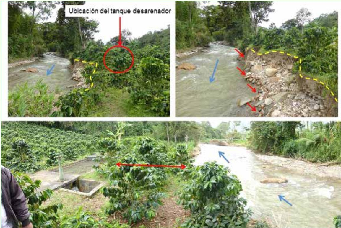
Imágenes que muestran el tanque desarenador del acueducto del distrito de riego Holanda-Limón en Bruselas, municipio de Pitalito. Nótese la socavación producida por las aguas del río Guachicos y la cercanía con el tanque.
