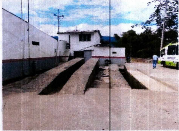
Fotografía 4. Cárcamo para el lavado de los vehículos.
