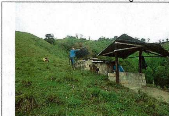
Fotografía 4. Filtro lento para tratar el agua
