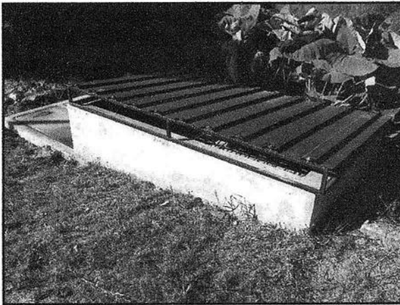
Trampa de grasas- tratamiento de aguas residuales para el vertimiento de aguas del lavado de vehículos
