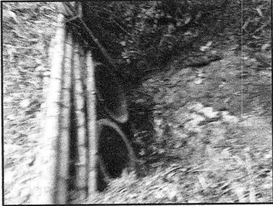
Tubería de 36", localizada sobre el cauce de la quebrada Aguamancha en donde se evidencia que el flujo hídrico pasa por debajo de los ductos.
